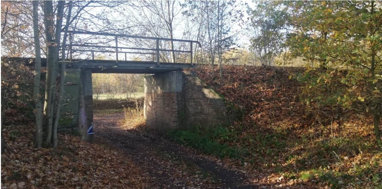
Abb. 21: Bahndamm mit Brücke am Weg nach Zürchel (Blick nach Süden 2020)
