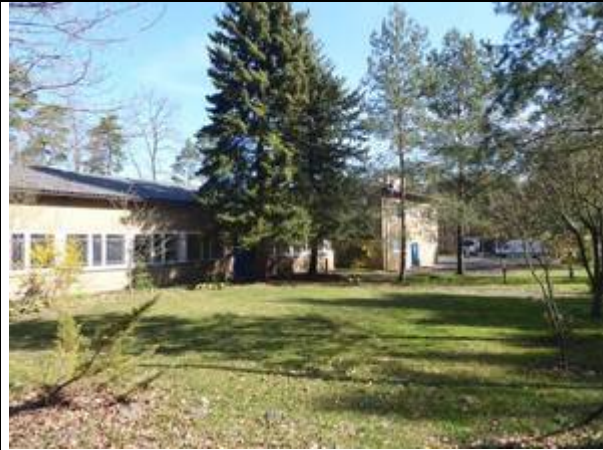
Foto 5: Lager- und Bürogebäude sowie Rasenfläche mit Gehölzen am Südostrand (Foto: Wiesner, 18.4.22)
